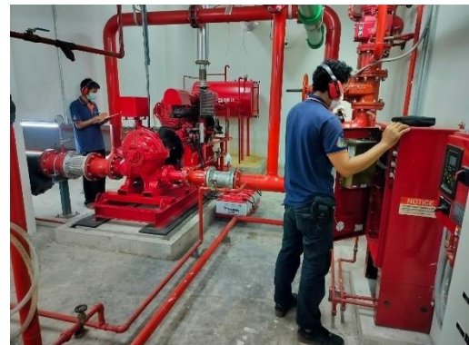
ตรวจสอบปั๊มสูบน้ำดับเพลิง
