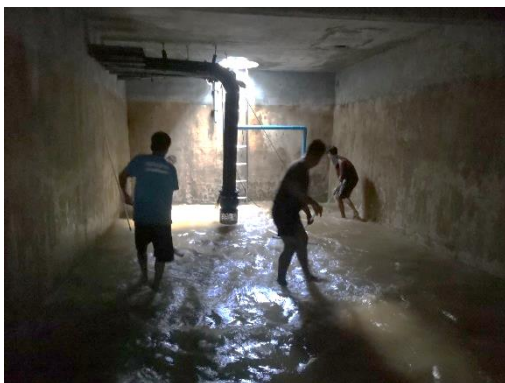
ภาพที่ 2-11 ล้างถังเก็บน้ำภายในโครงการ
