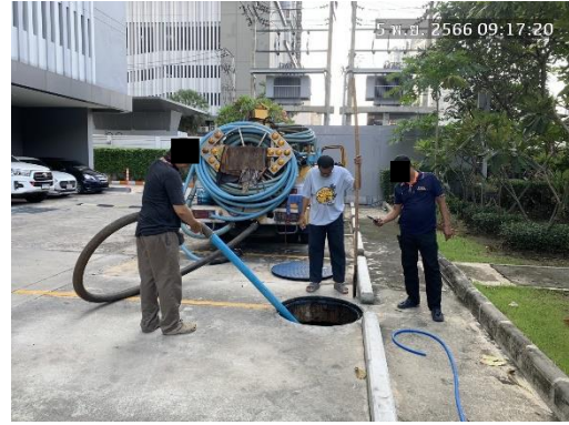
สูบน้ำส่วนเกินจากระบบบำบัดน้ำเสีย
